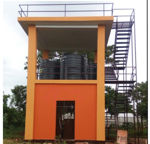
Wasserturm gepumpt. Von dort wird es an die entsprechenden Einrichtungen sowie Gärten verteilt. Der im August fertiggestellte Turm besitzt ein Fassungsvermögen von insg. 35.000 Liter.
